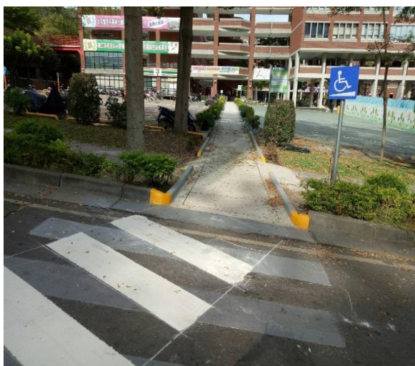
行政大 樓與戶 外電梯 間修建 無障礙 步道
