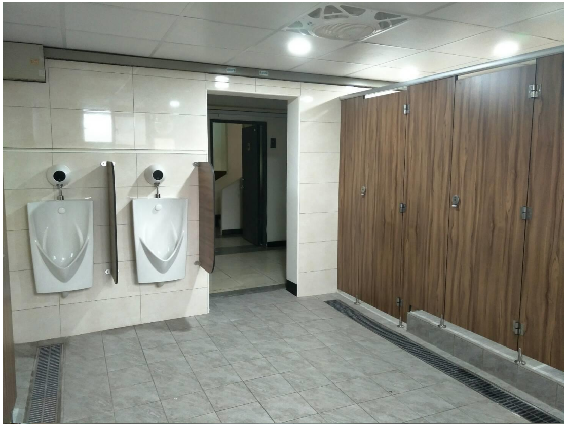
大葉學舍浴廁整修工程
