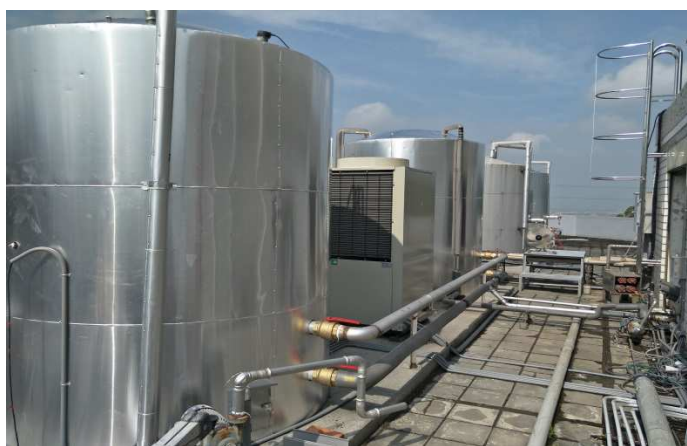
四肯學舍 C、D 區熱泵系統設備更新
